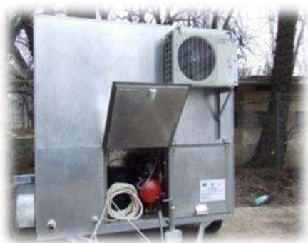
Sistemul automat este utilizat pentru monitorizarea online a calitatii apelor de suprafata / efluentilor epurati care sunt deversati in emisari naturali, prin determinarea, inregistrarea si transmiterea automata a concentratiilor unor indicatori specifici: pH, conductivitate electrica, temperatura, turbiditate, potential redox, oxigen dizolvat, azotat, amoniu, coeficientul de absorbtie spectrala SAC, fosfor total.
