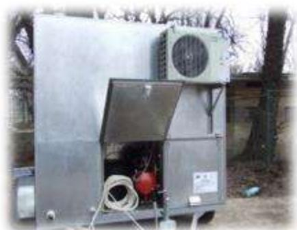
Sistemul automat este utilizat pentru monitorizarea online a calitatii apelor de suprafata / efluentilor epurati care sunt deversati in emisari naturali, prin determinarea, inregistrarea si transmiterea automata a concentratiilor unor indicatori specifici: pH, conductivitate electrica, temperatura, turbiditate, potential redox, oxigen dizolvat, azotat, amoniu, coeficientul de absorbtie spectrala SAC, fosfor total. Sistemul cuprinde la nivel local statia mobila cu principalele componente:
